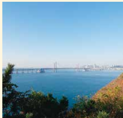
星海大橋全景
